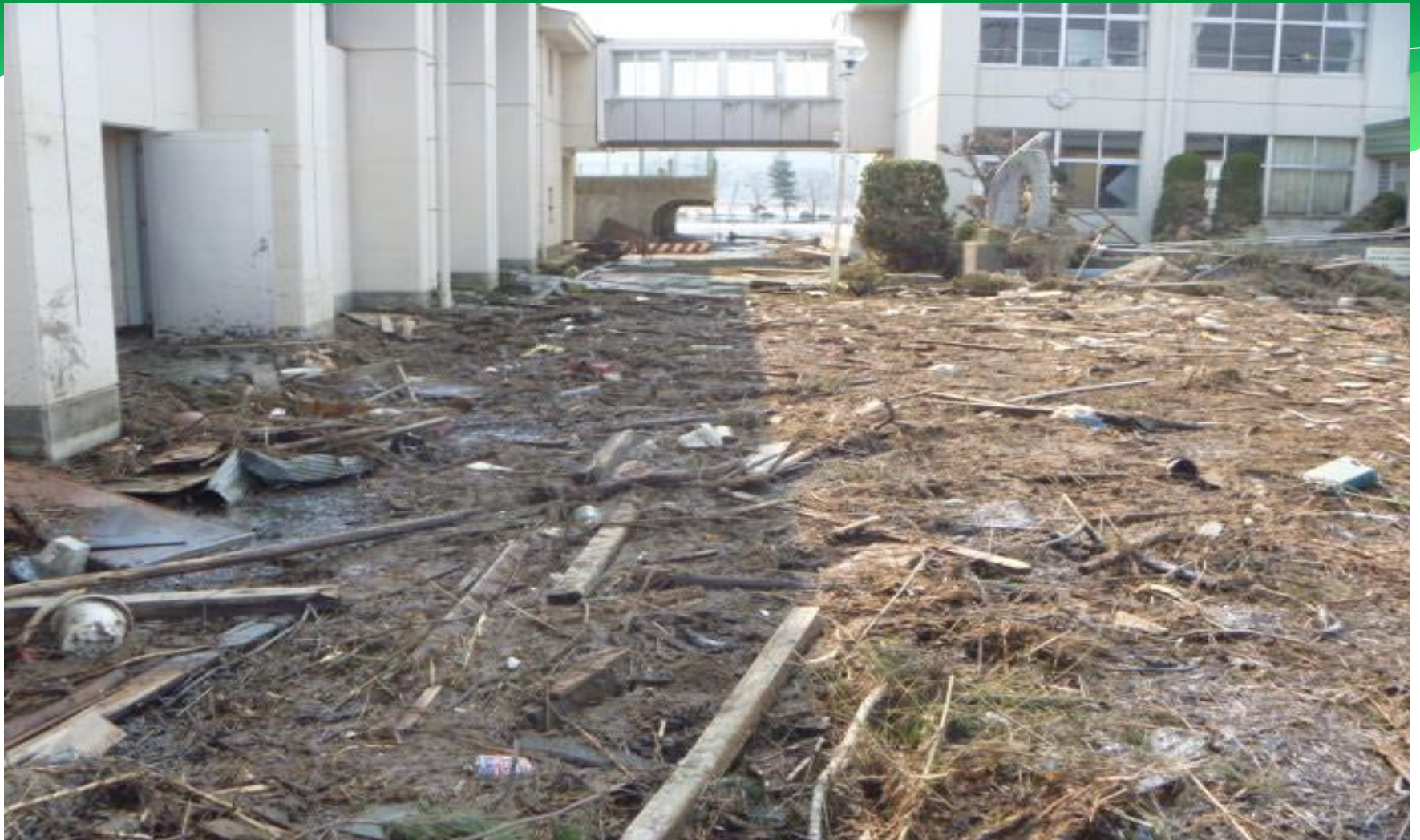
14. 2011. 3. 30 校舎体育館まで瓦礫 石巻市立大川中学校
